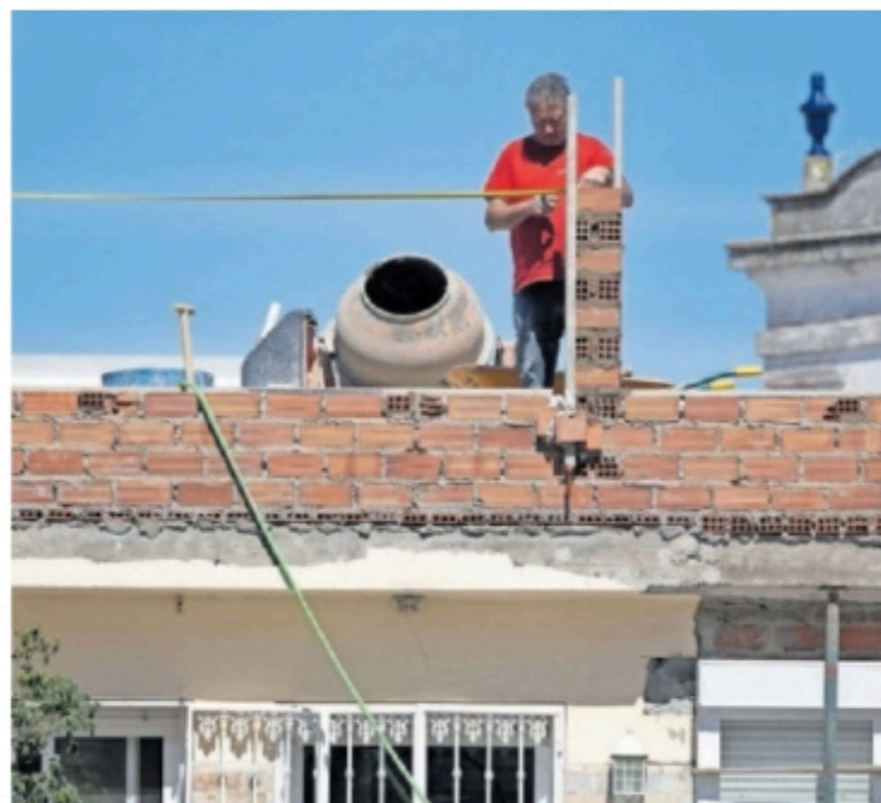
Trabajadores en Sevilla, a principios de abril. PACO PUENTES
